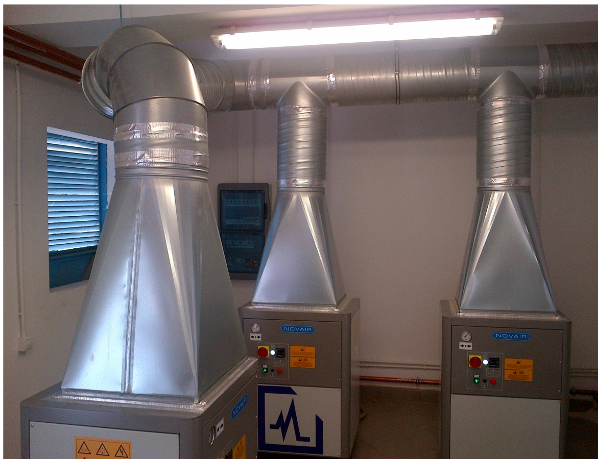
Rysunek 1 Przykład dodatkowej wentylacji sprężarek powietrza.
