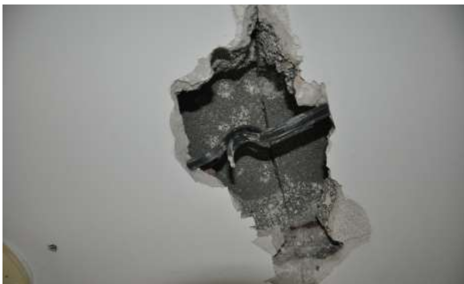
Fot. 18: Piwnice: pod pomieszczeniami 011 i 012 strop gęstożebrowy z monolitycznymi żebrami; pustaki żużłobetonowe o wysokości 15 cm;
