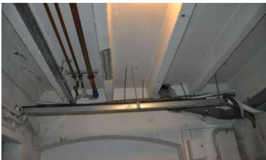
Fot. 14: Piwnice: w pomieszczeniu piwnicznym pod pomieszczeniem 029 strop płytowo-żebrowy;
