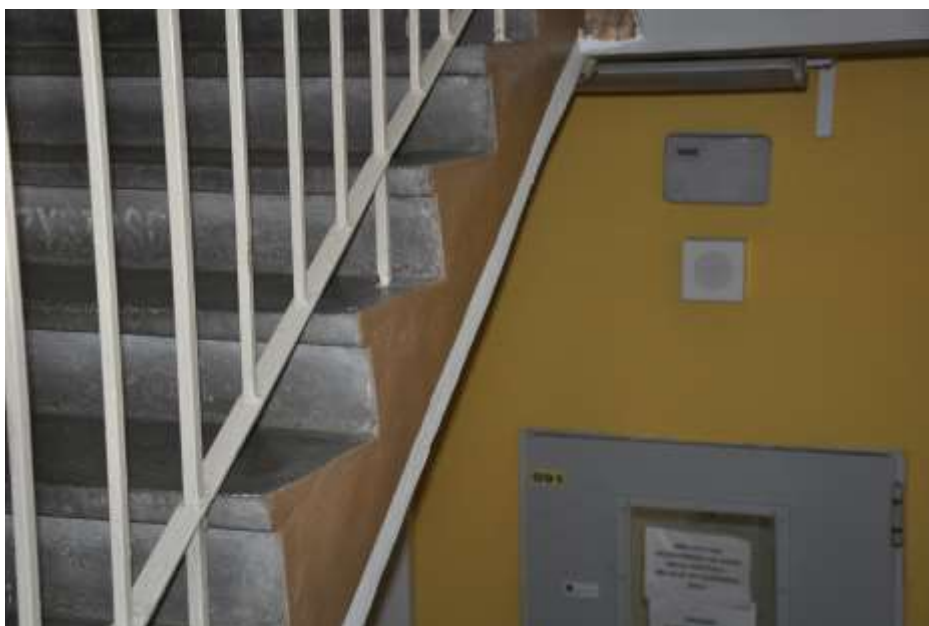
Fot. 29: Fragment biegu schodowego: stopnie i podstopnice wyłożone lastryko; stopnie ze śladami naturalnego zużycia;
