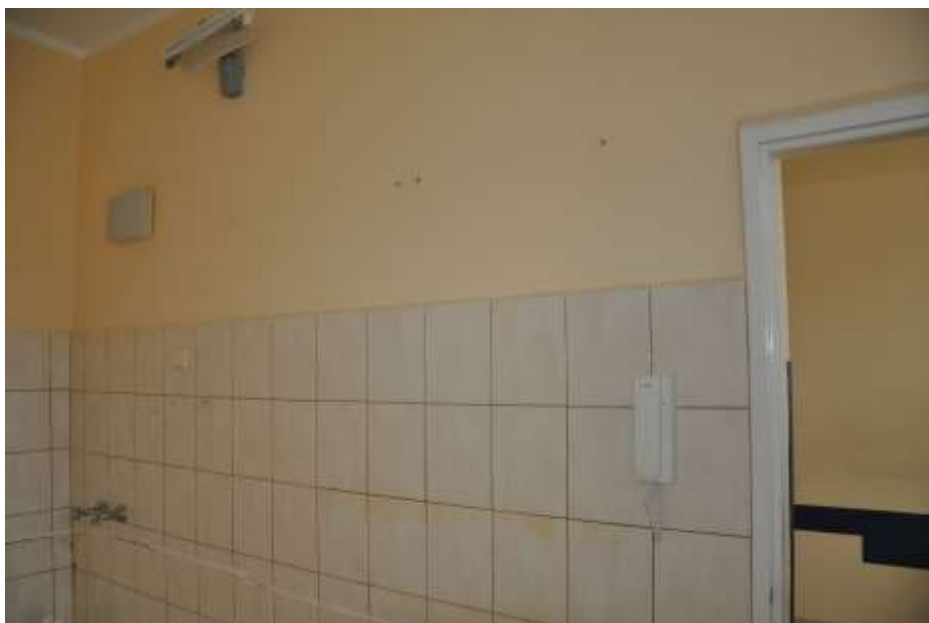
Fot. 12: Pomieszczenie nr 015: ściana działowa pomiędzy pomieszczeniami 015 i 016 o grubości 6 cm z okładziną z płytek;
