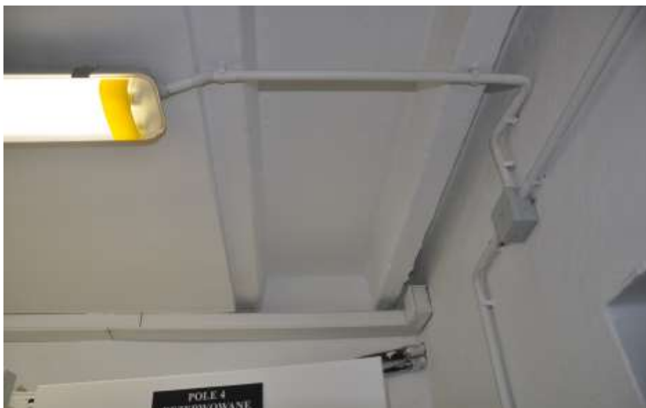
Fot. 16: Piwnice: pod помещением nr 028 w części strop płytowo-żebrowy; w części strop płaski;
