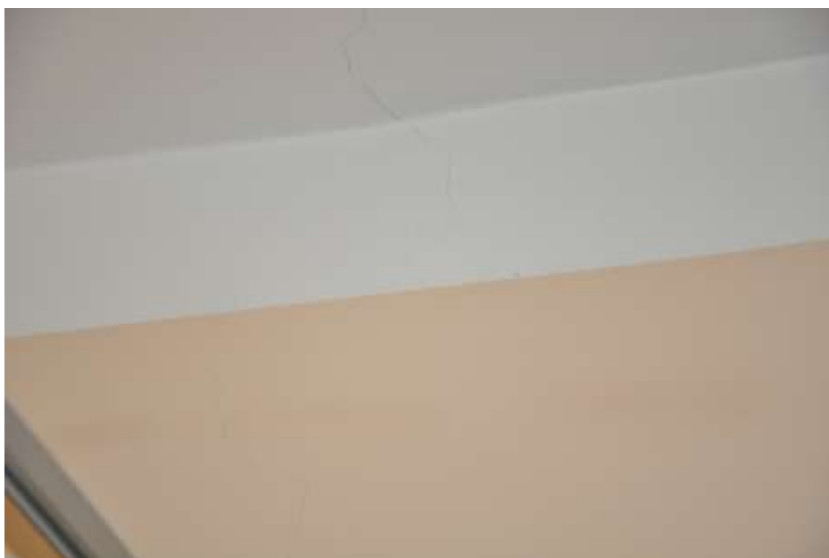
Fot. 11: Pomieszczenie 028: zarysowanie na ścianie poprzecznej będące kontynuacją zarysowania z sufitu;
