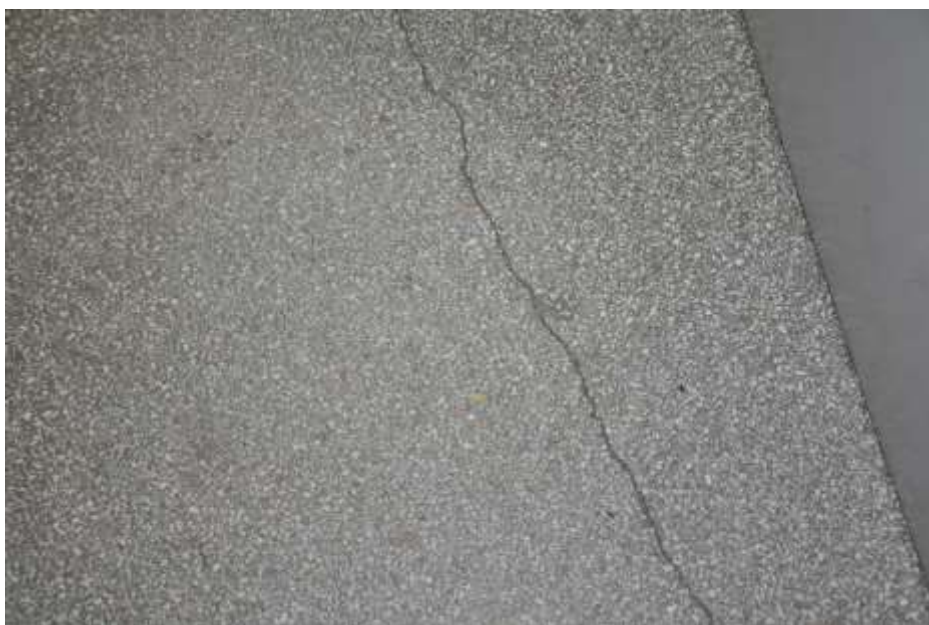
Fot. 30: Fragment schodów: zarysowania płyty spocznika;
