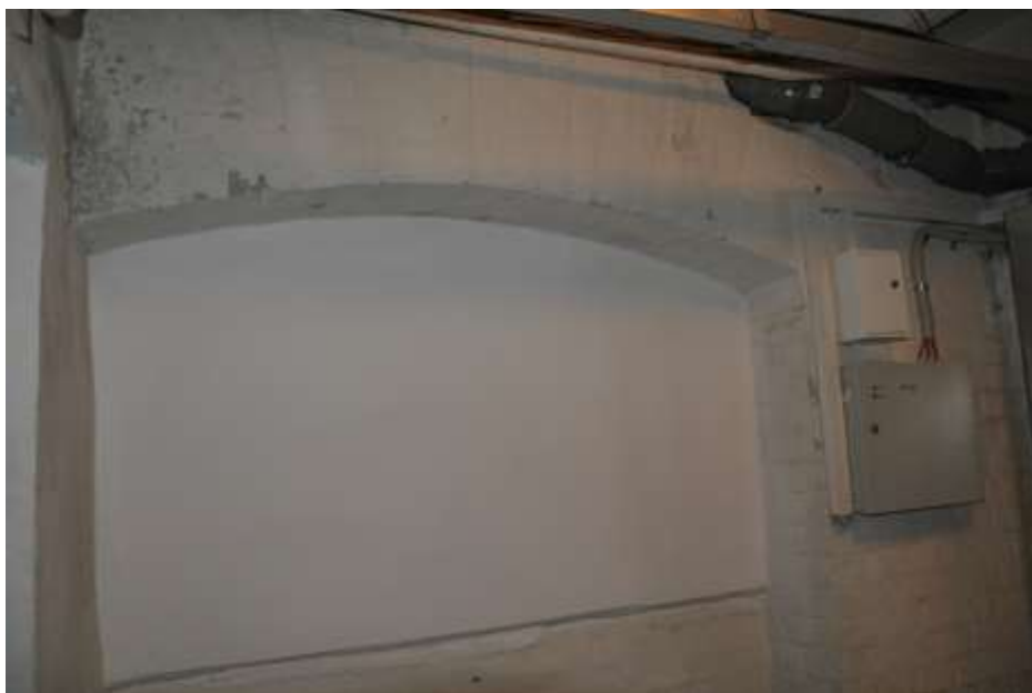
Fot. 6: Ściana wewnętrzna piwnicy: lokalnie w ścianie poprzecznej wnęka przesklepiona łukiem odcinkowym;
