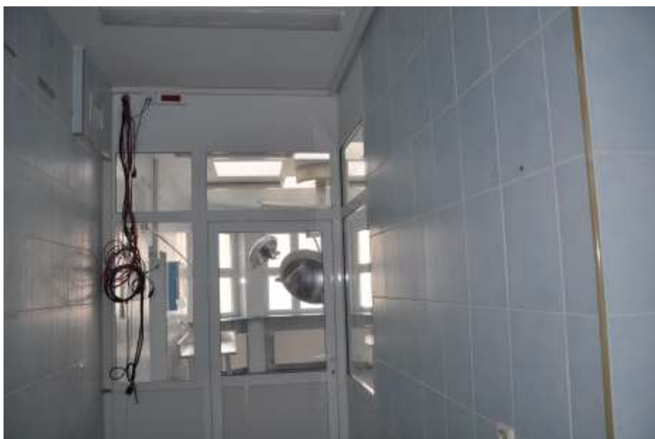
Fot. 9: Pomieszczenie 001: ścianki działowe pokryte płytkami ceramicznymi; - ściany w pomieszczeniu nr 028 tynkowane i malowane;
