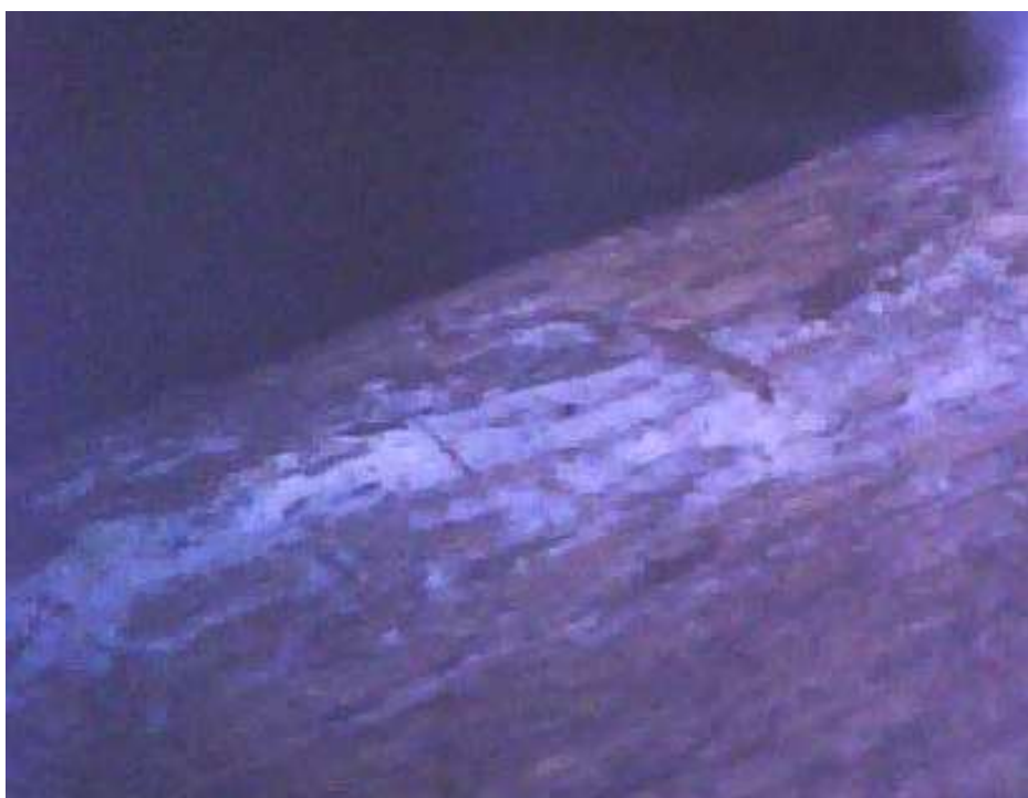
Fot. 28: Odkrywka w pomieszczeniu nr 028: elementy drewniane lokalnie porażone biologicznie;
