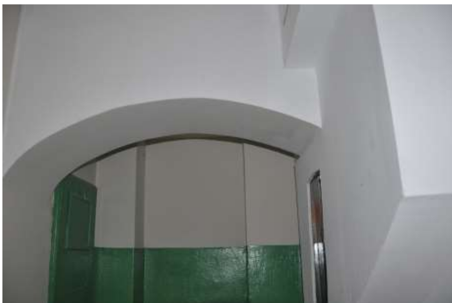
Fot. 26: Fragment stropu w pomieszczeniu nr 028: na przedłużeniu podciagu nadproże łukowe;
