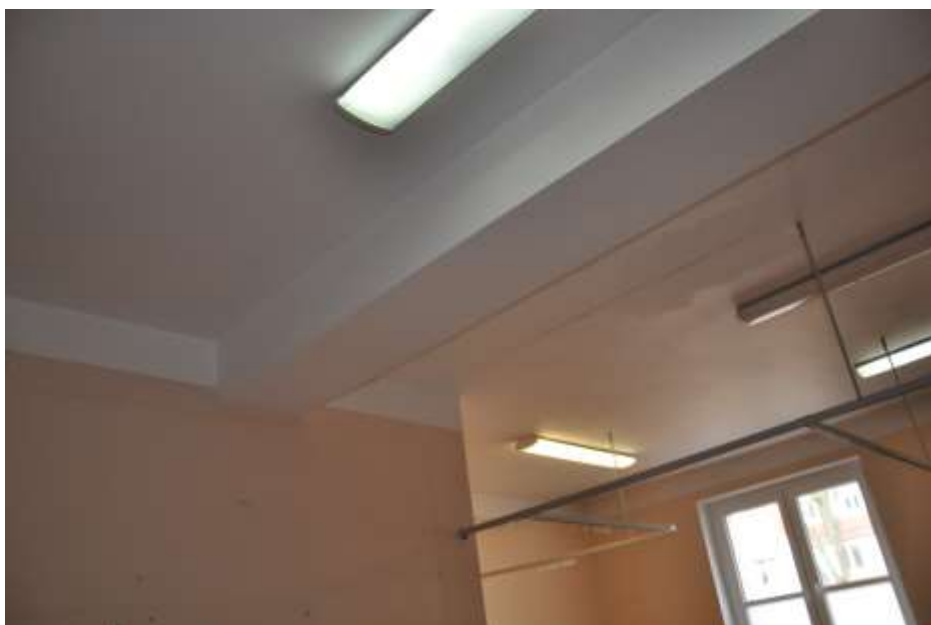
Fot. 25: Fragment stropu w pomieszczeniu nr 028: podciąg żelbetowy;
