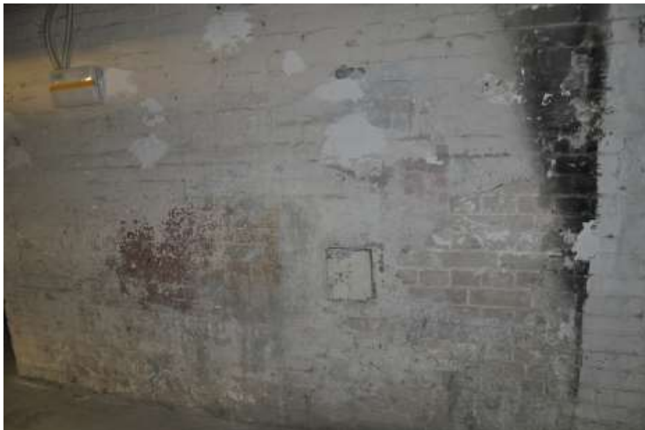
Fot. 4: Ściana wewnętrzna piwnicy: w ścianie kominy; rewizje;
