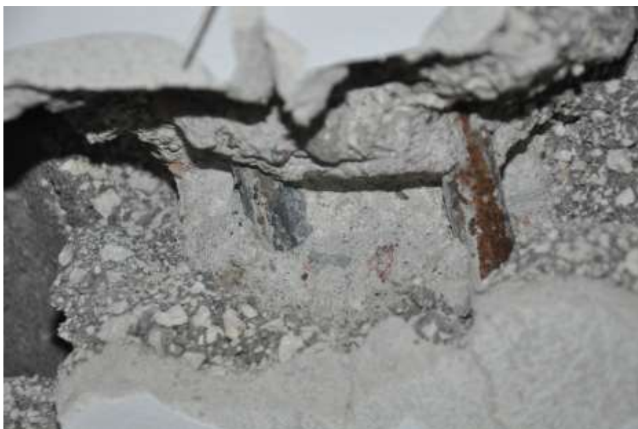
Fot. 19: Piwnice: żebro z dwóch prętów \varnothing 16 mm w rozstawie co 5 cm;
