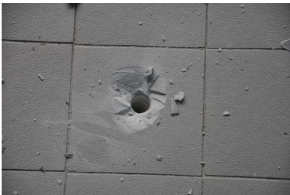
Fot. 20: Piwnice: na pustakach płyta żelbetowa grubości 8 cm; na posadce płytki ceramiczne;
