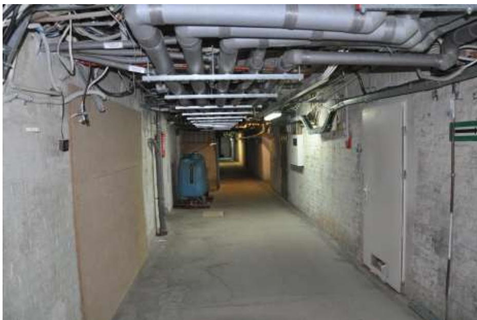
Fot. 3: Ściana wewnętrzna piwnicy: ściany podłużne korytarza grubości 51 cm; murowane z cegły ceramicznej pełnej; nietynkowane; białkowane;
