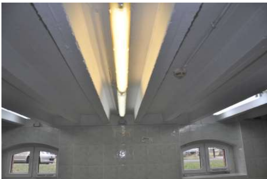
Fot. 17: Piwnice: w pomieszczeniu piwnicznym pod pomieszczeniem 015 strop płytowo-żebrowy; żebra o wysokości 15 cm i szerokości 12 cm w rozstawie co 53 cm;
