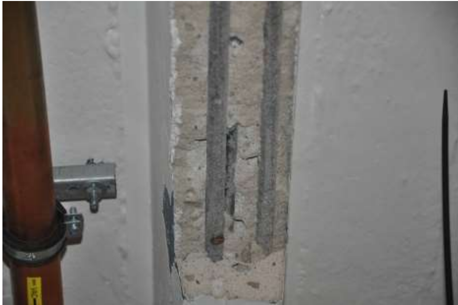
Fot. 15: Piwnice: żebro zbrojone dwoma prętami gładkimi \varnothing 16 mm i jednym \varnothing 8 mm;
