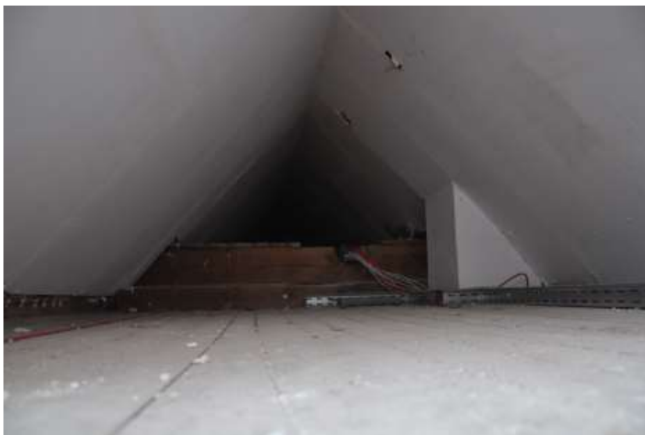
Fot. 31: Fragment konstrukcji dachu: więźba o konstrukcji płatwiowo-kleszczowej; na połaciach tynk na trzcinie;
