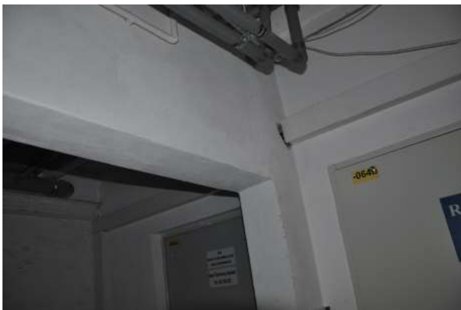
Fot. 7: Ściana wewnętrzna piwnicy: ścianki działowe w piwnicy o grubości 6 i 12 cm;
