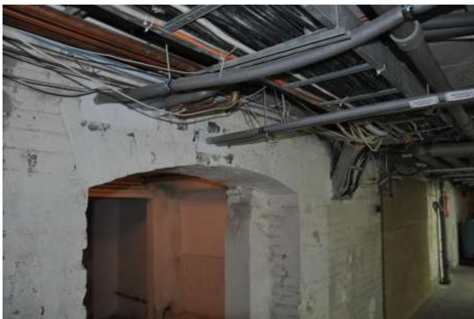
Fot. 5: Ściana wewnętrzna piwnicy: nadproża w ścianach wewnętrznych ceglane; odcinkowe;
