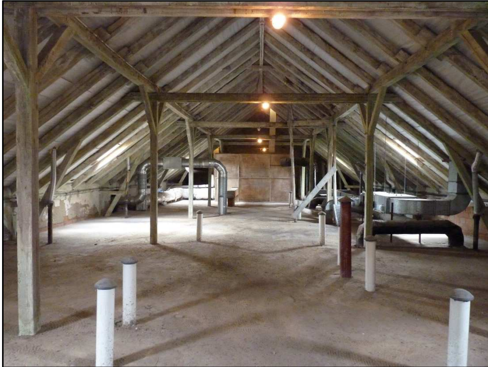
Fotografia 38. Widok na strych budynku „A”. Jest to potencjalne miejsce występowania nietoperzy.
