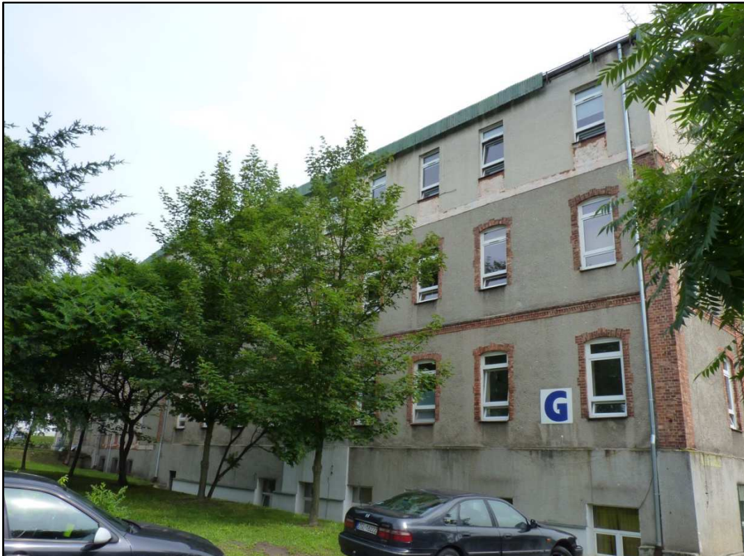
Fotografia 4. Widok na południowo zachodnią część budynku „G”.
