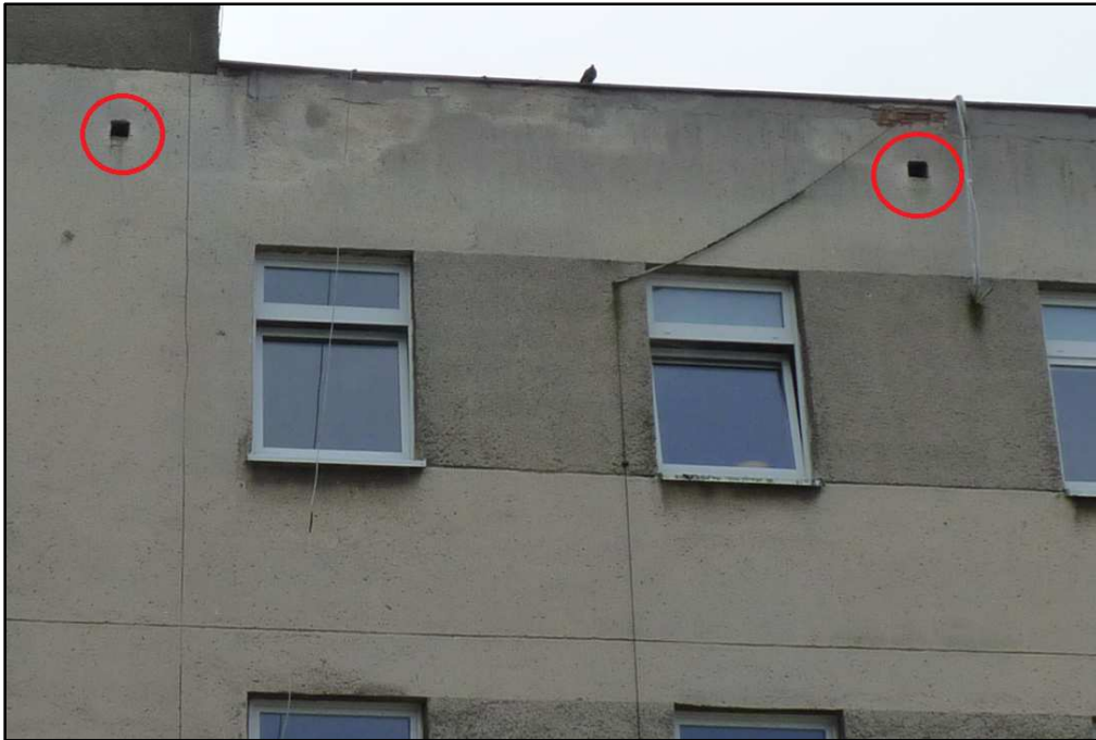
Fotografia 30. Niezabezpieczone otwory wentylacyjne w bocznej, północnej ścianie budynku „G” – dawne miejsca gniazdowania kawki zwyczajnej Corvus monedula . Potencjalne miejsca, w których ptaki ponownie mogą założyć gniazda.
