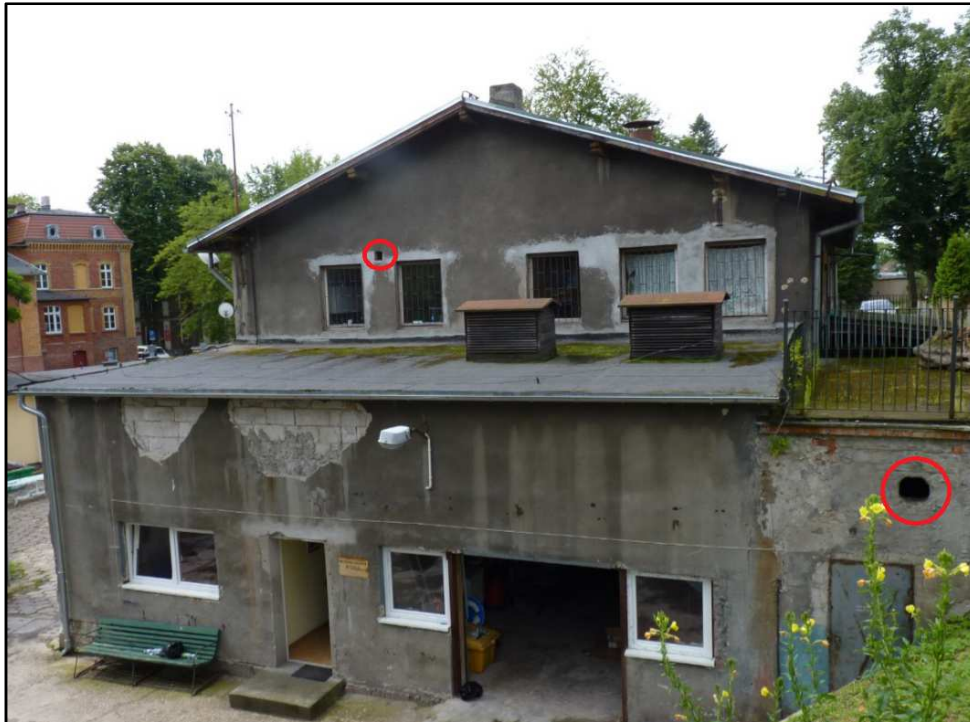
Fotografia 36. Północna część budynku. W elewacji zaznaczono otwory, stanowiące potencjalne siedliska ptaków.
