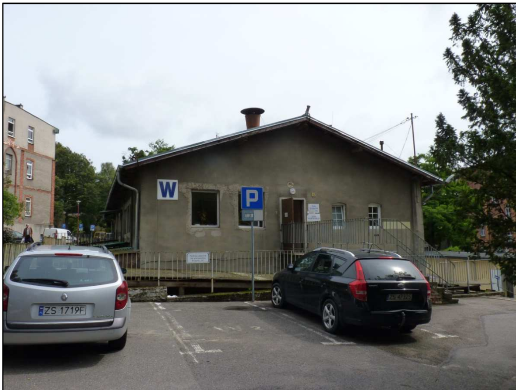
Fotografia 5. Widok na południową część budynku „W”.
