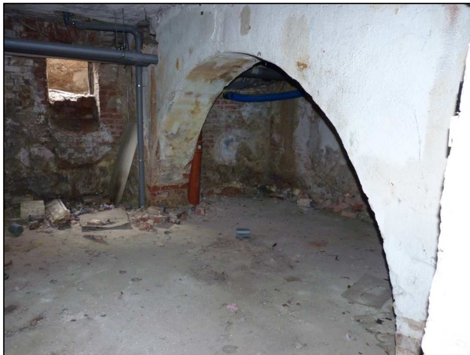
Fotografia 23. Jedno z mało użytkowanych pomieszczeń piwnicznych budynku „B”. Otwarty, niezabezpieczony otwór okienny. Miejsce, gdzie ptaki mogą założyć gniazda.
