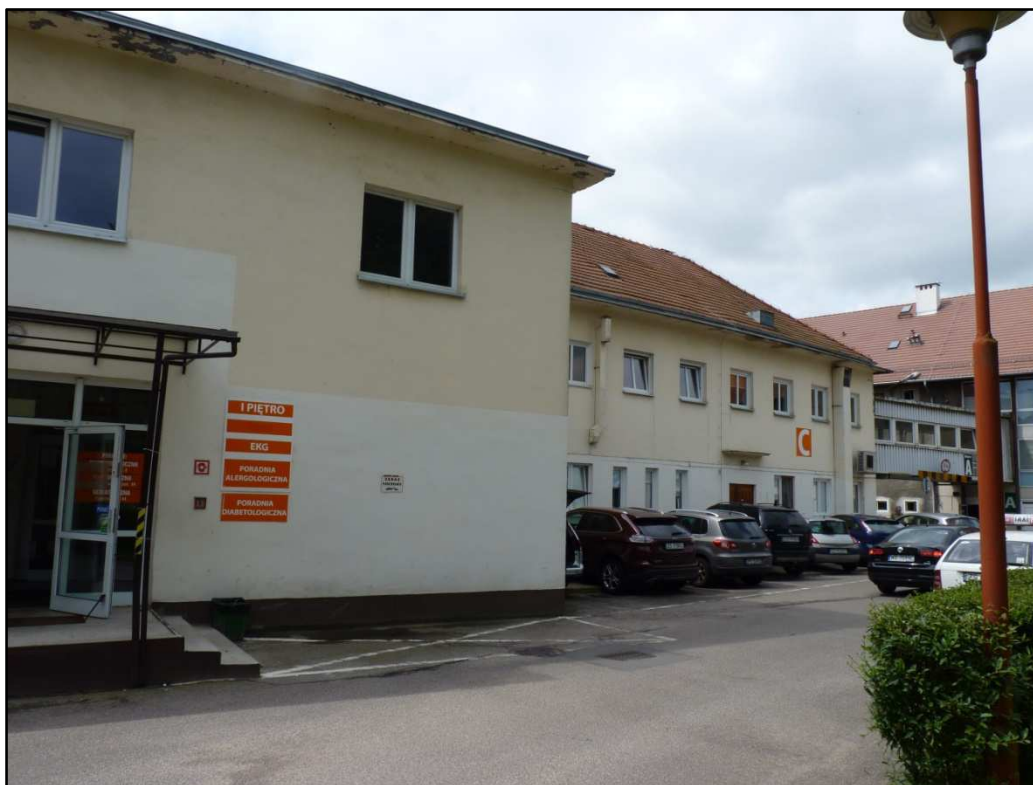
Fotografia 3. Widok z ul. Arkońskiej na część budynku „C”.
