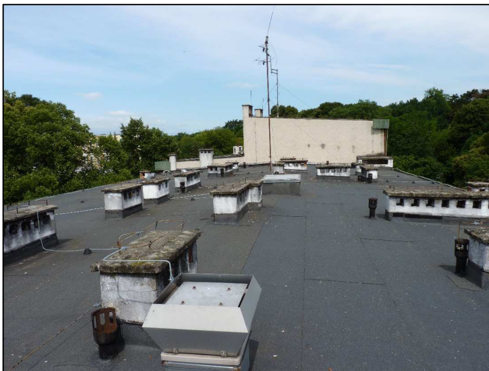
Fotografia 33. Widok na dach budynku „G”. Nie stwierdzono tu obecności gniazd ptasich, jedynie ich ślady przebywania.
