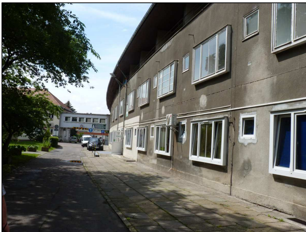
Fotografia 1. Widok w kierunku południowo zachodnim na część budynku „A”.
