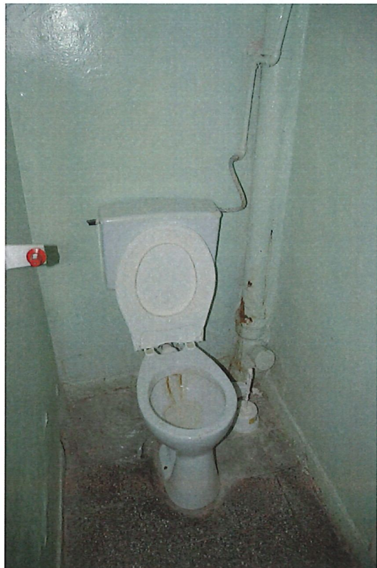
Zdjęcie nr 15 (po lewej) – Piwnica – korytarz. Widoczne liczne zawilgocenia oraz ubytki tynku. Zdjęcie nr 16 (po prawej) – Piwnica – WC. Widoczne skorodowane rury instalacyjne. Zniszczona posadzka.
