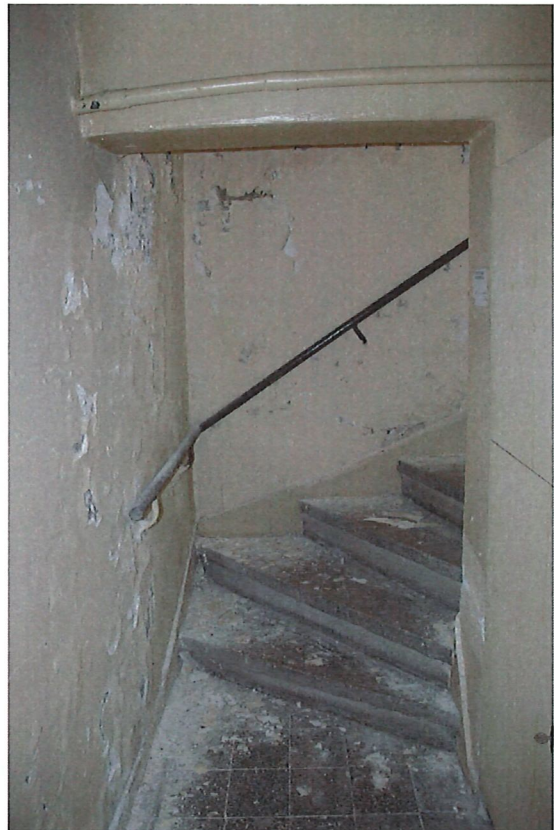
Zdjęcie nr 13, nr 14 – Klatka schodowa wewnątrz budynku. Na klatce występują liczne zawilgocenia, zagrzybienia oraz korozja biologiczna (grzyby pleśniowe). Widoczne również ubytki w tynku.
