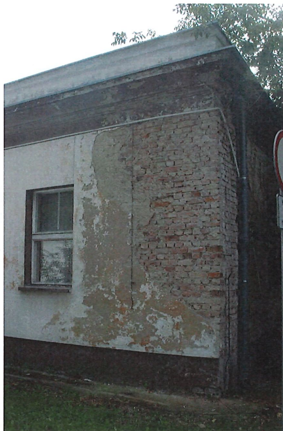
Zdjęcie nr 9 (po lewej) – Elewacja północna. Widoczne liczne zawilgocenia oraz ubytki tynku. Zniszczony murek pochylni wejściowej do budynku.
