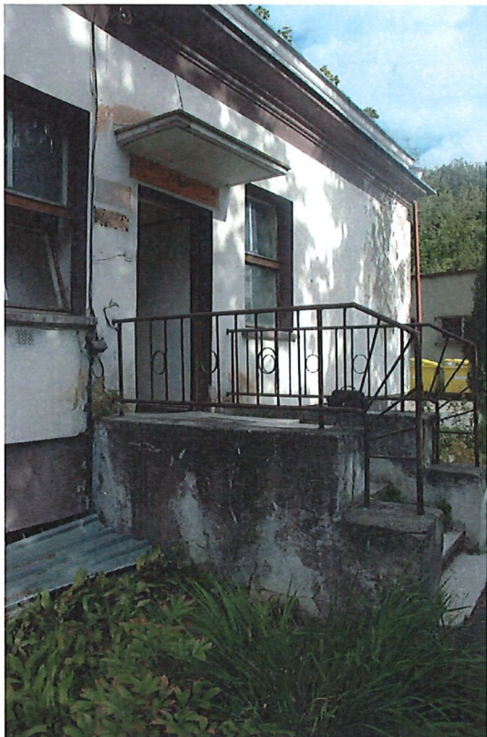
Zdjęcie nr 3, nr 4 – Elewacja południowa – wejście do budynku. Widoczne zawilgocenia oraz ubytki tynku. Zniszczone, popękane ściany boczne schodów oraz ubytki w schodach.
