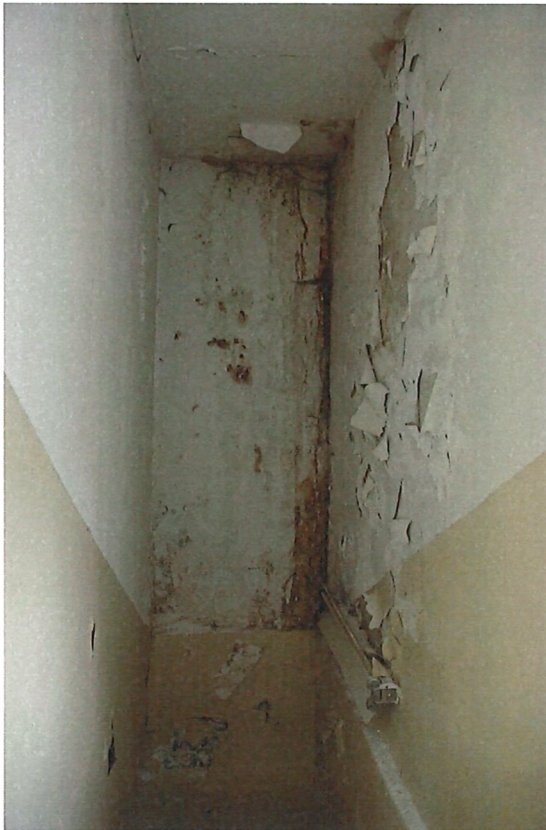
Zdjęcie nr 13, nr 14 – Klatka schodowa wewnątrz budynku. Na klatce występują liczne zawilgocenia, zagrzybienia oraz korozja biologiczna (grzyby pleśniowe). Widoczne również ubytki w tynku.
