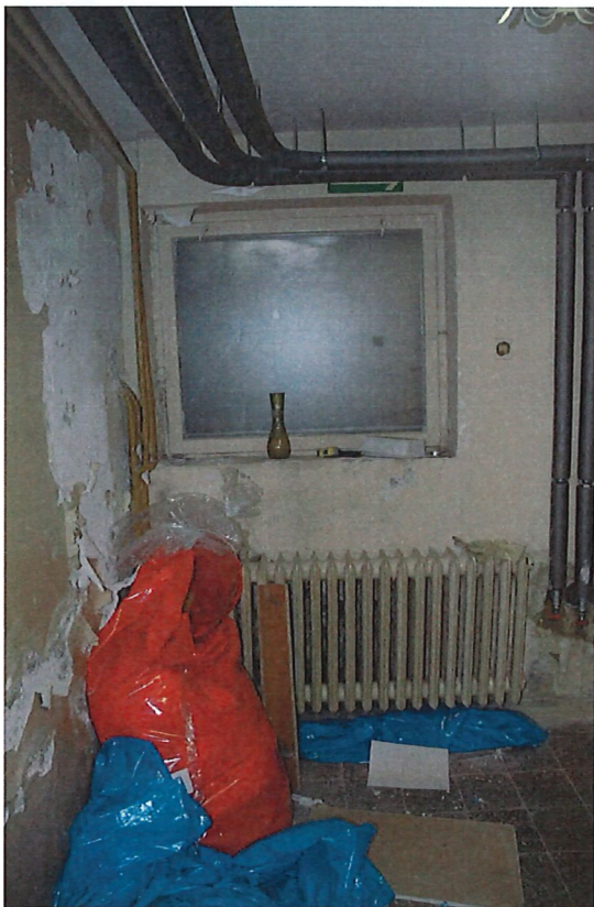
Zdjęcie nr 15 (po lewej) – Piwnica – korytarz. Widoczne liczne zawilgocenia oraz ubytki tynku. Zdjęcie nr 16 (po prawej) – Piwnica – WC. Widoczne skorodowane rury instalacyjne. Zniszczona posadzka.
