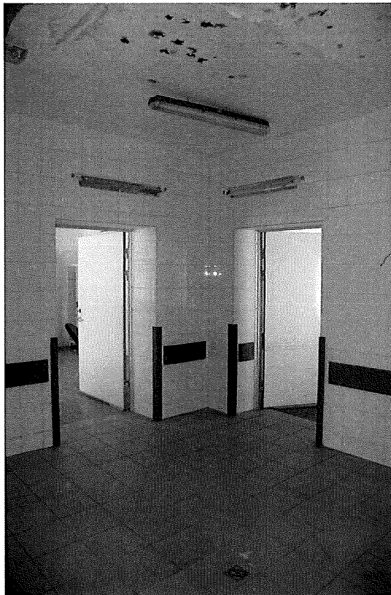
Zdjęcie nr 23 (po lewej) – Parter – chłodnia. Na stropie – widoczne liczne zawilgocenia oraz wykwity. Tynk w wielu miejscach odpada. W pomieszczeniu panuje nieprzyjemny zapach.
