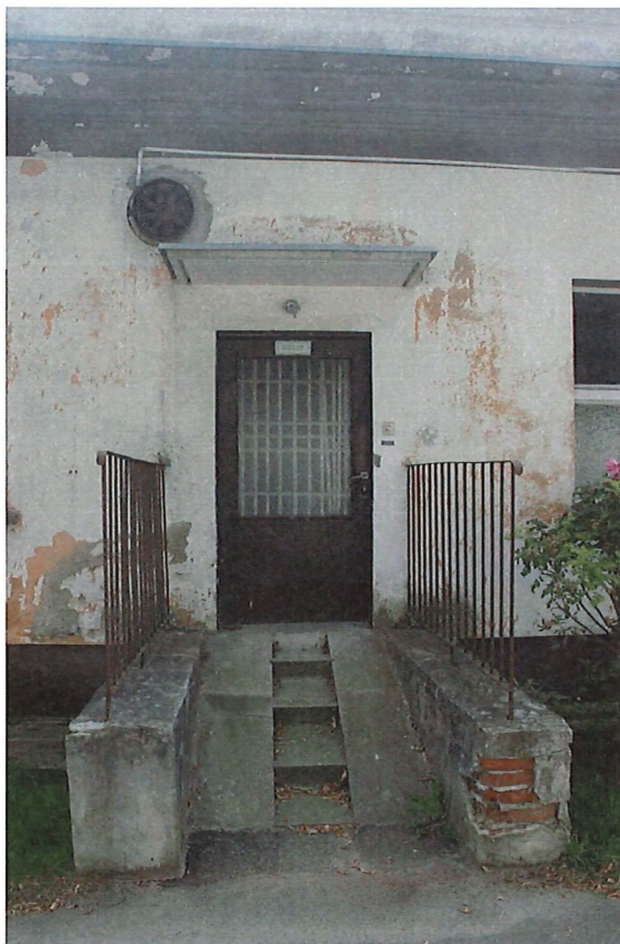
Zdjęcie nr 9 (po lewej) – Elewacja północna. Widoczne liczne zawilgocenia oraz ubytki tynku. Zniszczony murek pochylni wejściowej do budynku.
